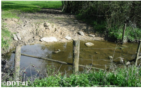
©DDT 41 Destruction de berge par le pâturage et installation d'une clôture dans le cours d'eau.
