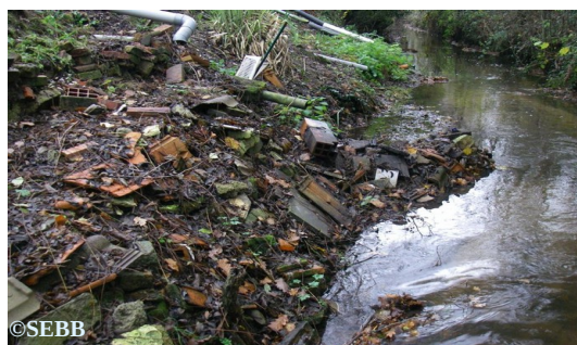
Remblais en bordure de cours d'eau par des matériaux divers.
