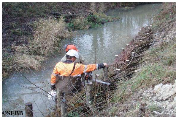
Mise en place d'une fascine de saule en pied de berge. Les racines des arbres ainsi plantés maintiendront la berge.
