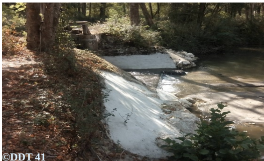
Utilisation de béton pour le renforcement de la berge.
